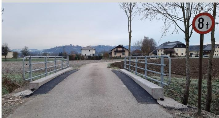
Die Sanierungsarbeiten an der "Behambrücke" gingen planmäßig voran und die Freigabe für den Verkehr erfolgte am 30.11.2023. Durch die senkrecht montierten Eisenstangen ist nun auch ein den heutigen Vorschriften entsprechendes Brückengeländer angebracht worden. Weiters wurde ein beidseitiger Betonsockel als Radabweiser durch die Mitarbeiter des Wirtschaftshofes mit Unterstützung des Wegehaltungsverbandes Hausruckviertel errichtet.
