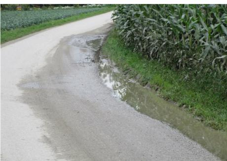
WIHOF-Aschachtal von einer externen Firma die erhöhten Bankette auf das Niveau der bestehenden Asphaltdecken abgezogen und in Absprache mit den landw. Grundanrainern das gewonnene Erdmaterial dem Ackerboden wieder zugeführt.
